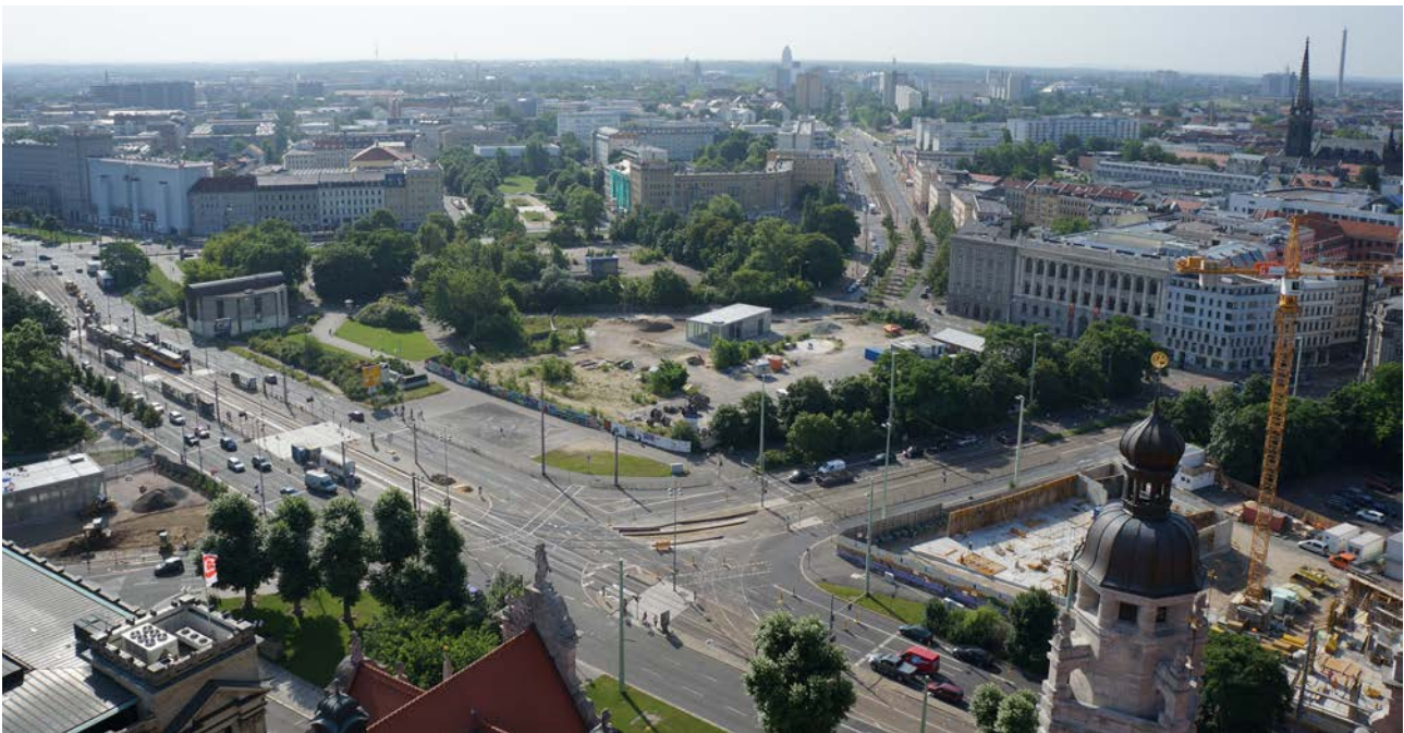
Abb.1 Situation 2013: Noch besteht die Chance, an die frühere städtebauliche Ensemblekraft anzuknüpfen und das Areal urban, kleinteilig und attraktiv zu entwickeln.
