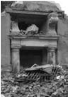
Abb. 2 Leipzig-Reudnitz, Köbiss- straße 11 (erbaut um 1900), wohlerhaltenes herrschaft- liche Wohnhaus im Stadt- teilzentrum abgebrochen im August 2006
